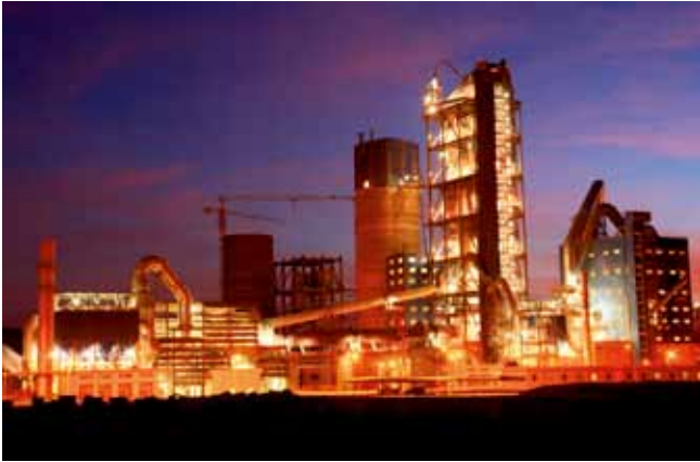
沙特RCC二期日产5000吨水泥生产线总包项目
